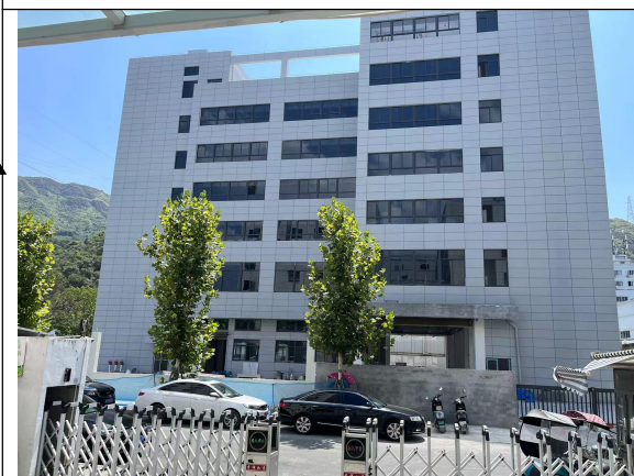
南侧：瓯江路，隔路为中南仪器仪表有限公司
